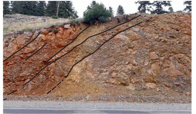
Şekil 8: Yiğiltaş Tepe ile Abanoz yolu üzerinde yer alan demir ve boksit sıvanımlı ezik, breşik zonlar ve küçük ölçekli ters faylar
