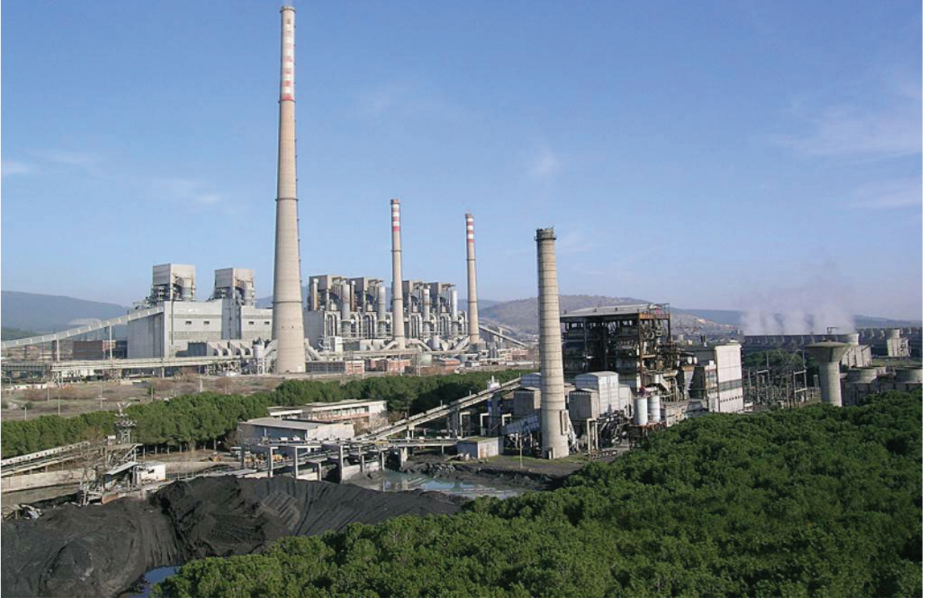
Şekil 5: Soma Termik Santrali
